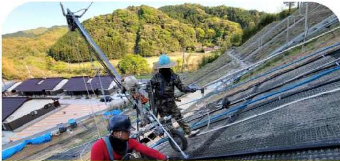
**CHECK!** 鉄筋を直打ちで法面に挿入するため※、セメントミルク注入などの**作業工程が省略可能**
