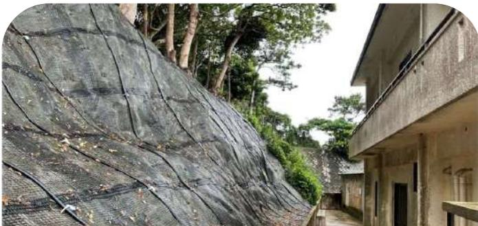
**CHECK!** 大規模な法面整形や大型重機を必要としないため、**狭所での施工も可能**
