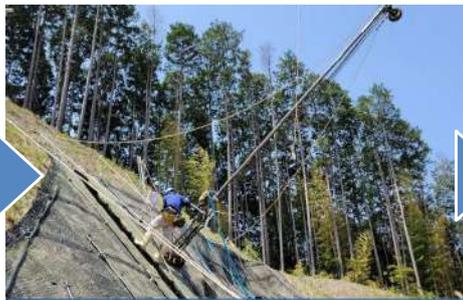
4. ソイルネイル(補強鉄筋)挿入
