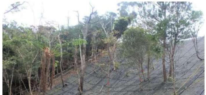
**CHECK!** 資材が軽量で加工が容易なため、**地山に沿った残林施工が可能**
