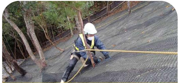
**CHECK!** 法面整形後に高強度マットを敷設するため※**施工中から表土の浸食防止が可能**
